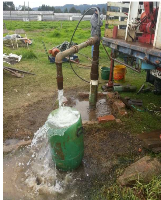
Descarga del Flujo de Agua por la Inyección de Aire Comprimido
